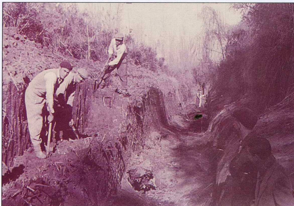
Construcción de un canal en tierra ▲ en 1956, Montecaseros. Mendoza.
