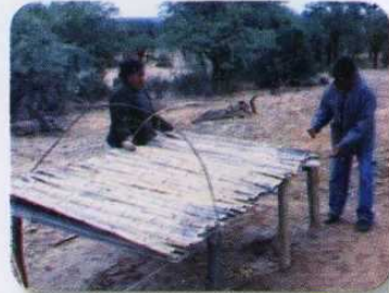
Construcción de secadero con base de cañizo.
